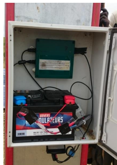
Matériel installé dans le caisson. Le SM2Bat+ est alimenté par une batterie lui procurant 3 semaines d'autonomie
